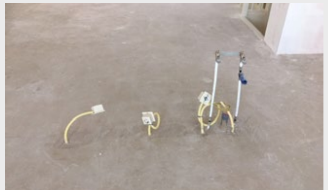
Aansluitpunten voor de keuken.
